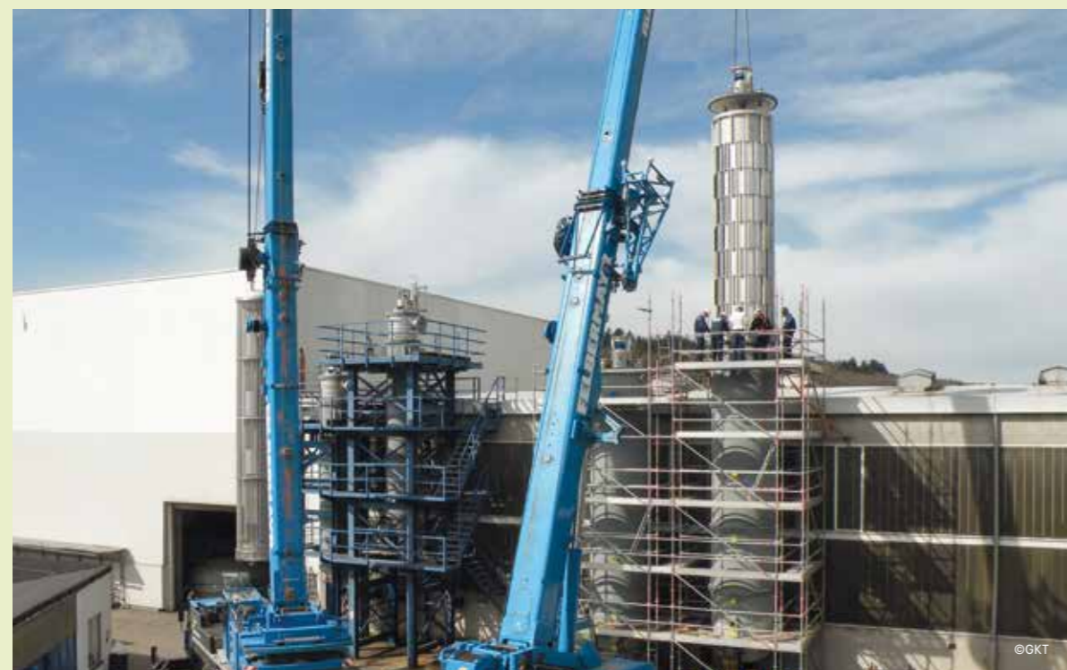
Einbau eines Kurzwegverdampfers
